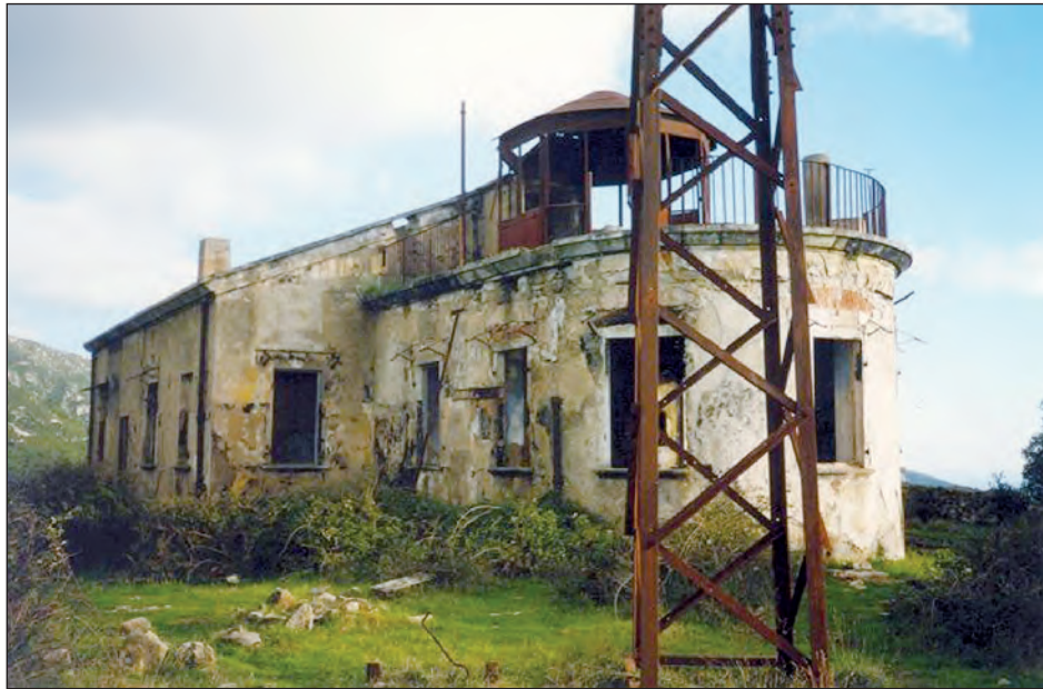
Fig.16 - Il corpo di fabbrica del semaforo di Campo alle Serre. In secondo piano, coperti a capanna, i locali per l'alloggio del personale. In primo piano i locali di servizio con la terrazza per le osservazioni, orientata verso il mare (foto da http://www.elbafortificata.it/Semaforo%20chiessi.jpg , 30.4.2016)
